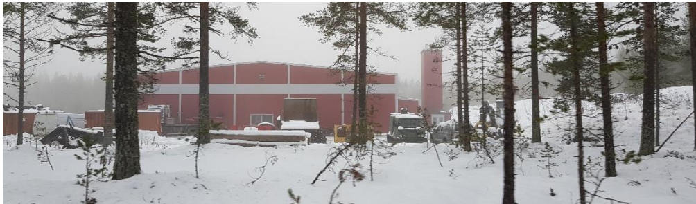
Figur 7: Befintlig byggnad i planområdet, verksamhet bedrivs av Lima Tvätten AB
