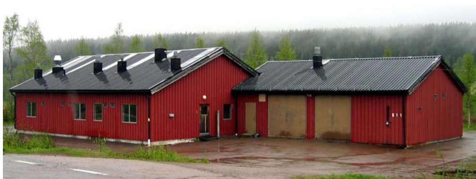
Sälens by avloppsreningsverk
