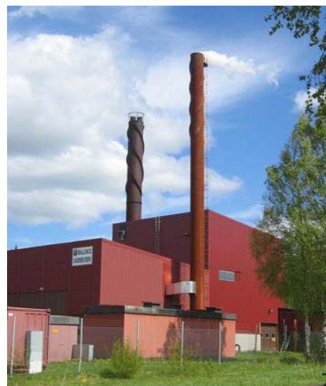
Värmeverket i Malung
