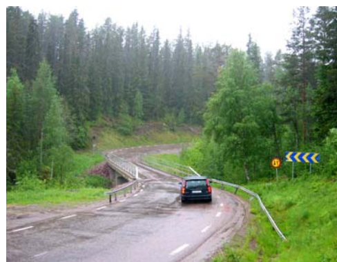
Länsväg 311 vid Hormundsvalla
