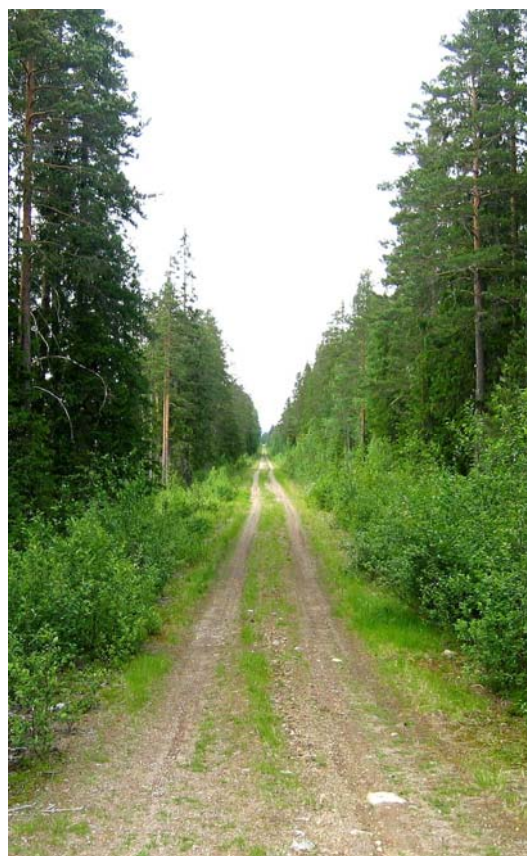
Järnvägsbanken norr om Malungsfors
