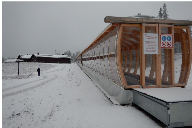
Ett transportband leder upp till liften Söderåsen Express.
