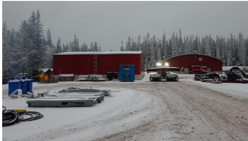
Pistmaskinsgarage och förrådsbyggnad i södra delen av planområdet.
