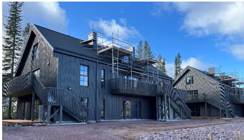
Lägenhetshus under uppförande i Fjällbäcken.
