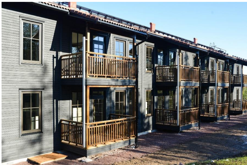
Lägenhetshus (Ski House 303) i mellersta västra delen.
