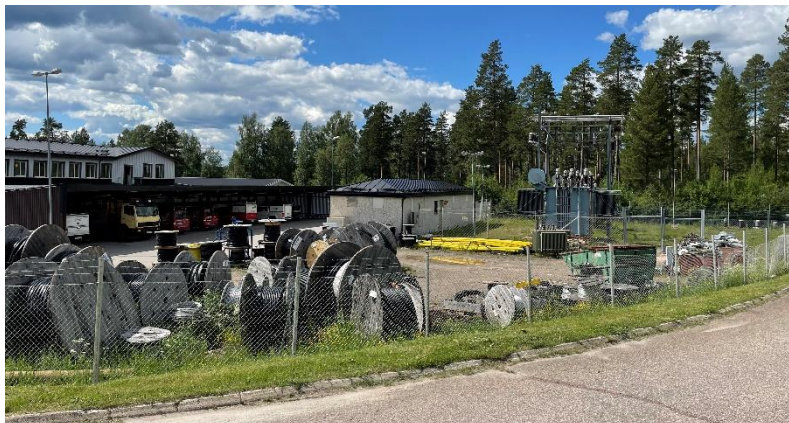
Del av befintlig lageryta.
