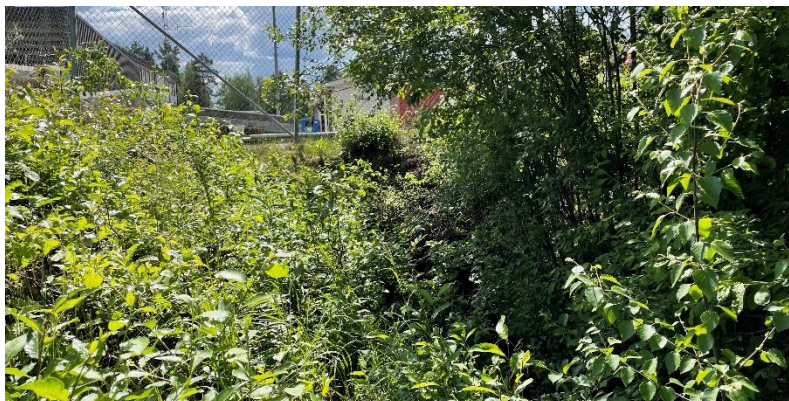
Bäckens/dikets start på kulvertering.
